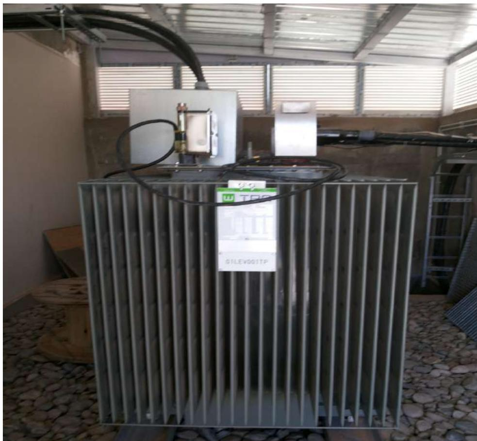
**Figure (A-2) : Transformateur Elévateur de Kiosque**
