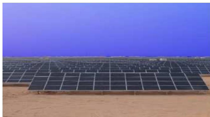
Figure (II-12) : Centrale solaire photovoltaïque d'Adrar (20MWc) 2015
