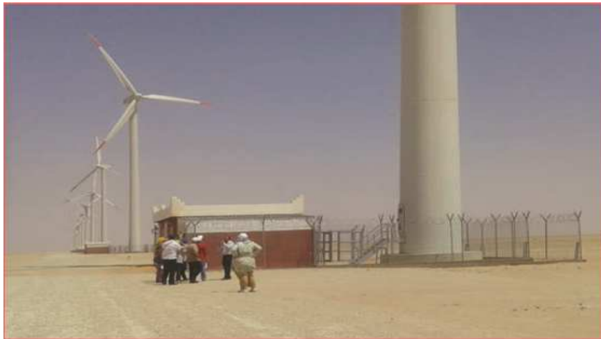
Figure (II-23) : La ferme éolienne 2015
