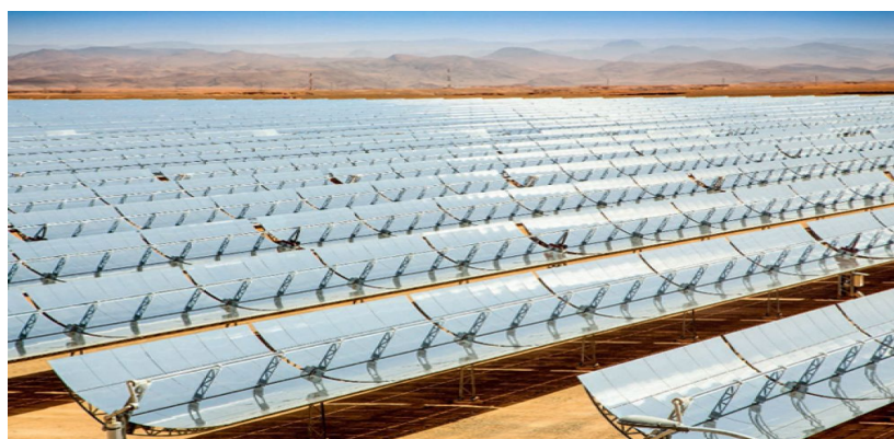
Figure (I-16) : Le complexe de Noor, près de Ouarzazate, Maroc
