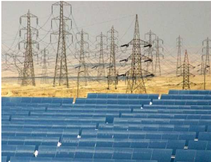
Figure (II-9): Projet de 350MW d'énergie solaire de L'Italien ENI en Algérie.
