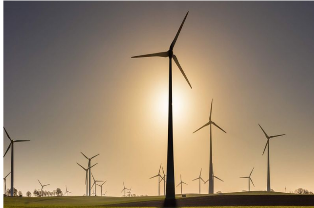
Figure (I-5) : Photos d'un parc éolien
