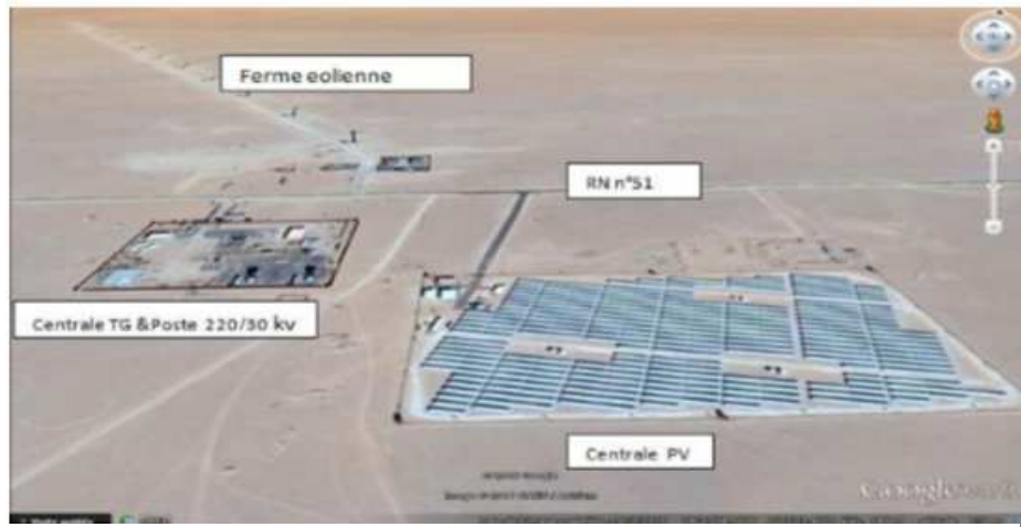
Figure (II-21) : Implantation de la ferme éolienne de KABERTENE
