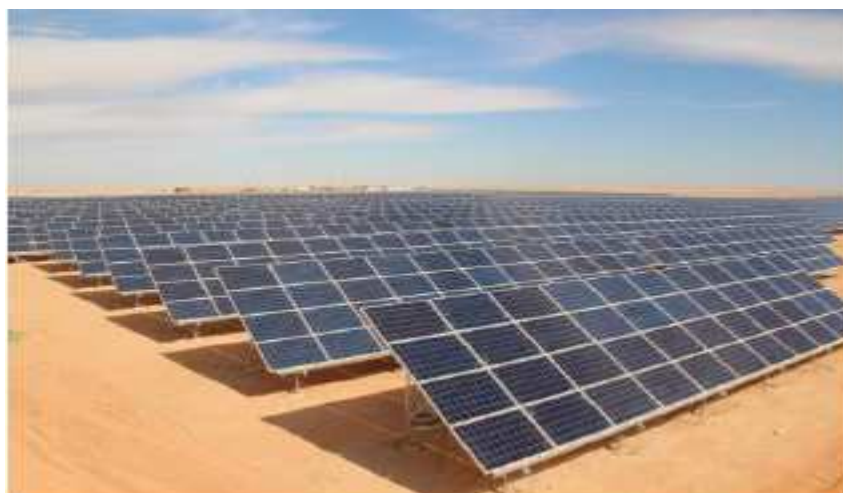
Figure (II-11) : Centrale solaire photovoltaïque de Kabertène (03MWc) 2015
