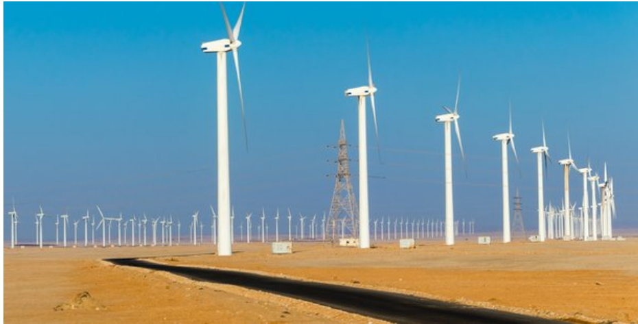
Figure (I-26) : Projet de grand parc éolien d'Afrique-Kenya
