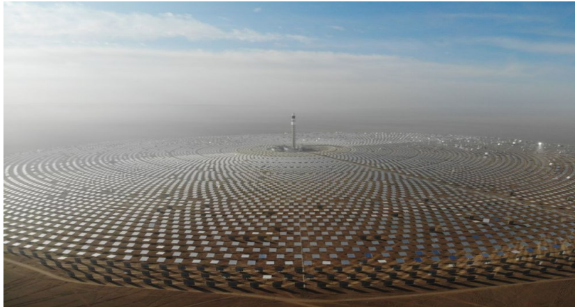
Figure (I-15) : La plus grande centrale solaire asiatique a concentration 2018
