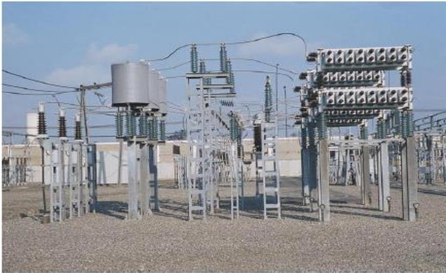
**Figure II.6 :** Gradins de condensateurs placés sur le réseau HTA (63 kV) permettant de compenser la puissance réactive de la charge.
