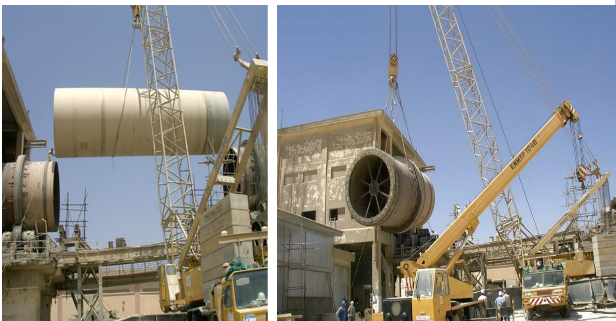
Figure 11: Changement de tronçons de virole four
