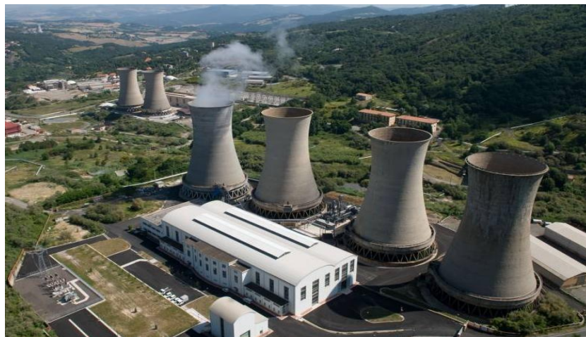
Figure (I.11): Centrale géothermique.
