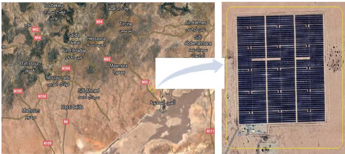
Figure (IV.3). La répartition de centrale photovoltaïque au niveau de Saïda par (MAPS).
