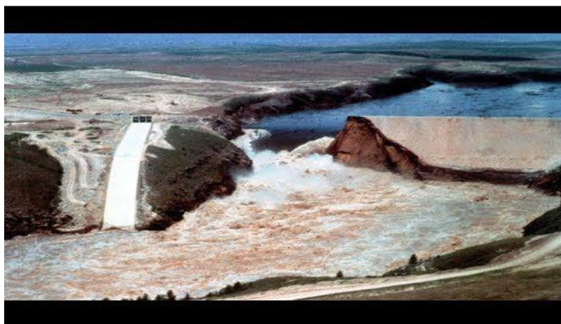
Figure I.9 : Rupture du barrage Teton, USA
