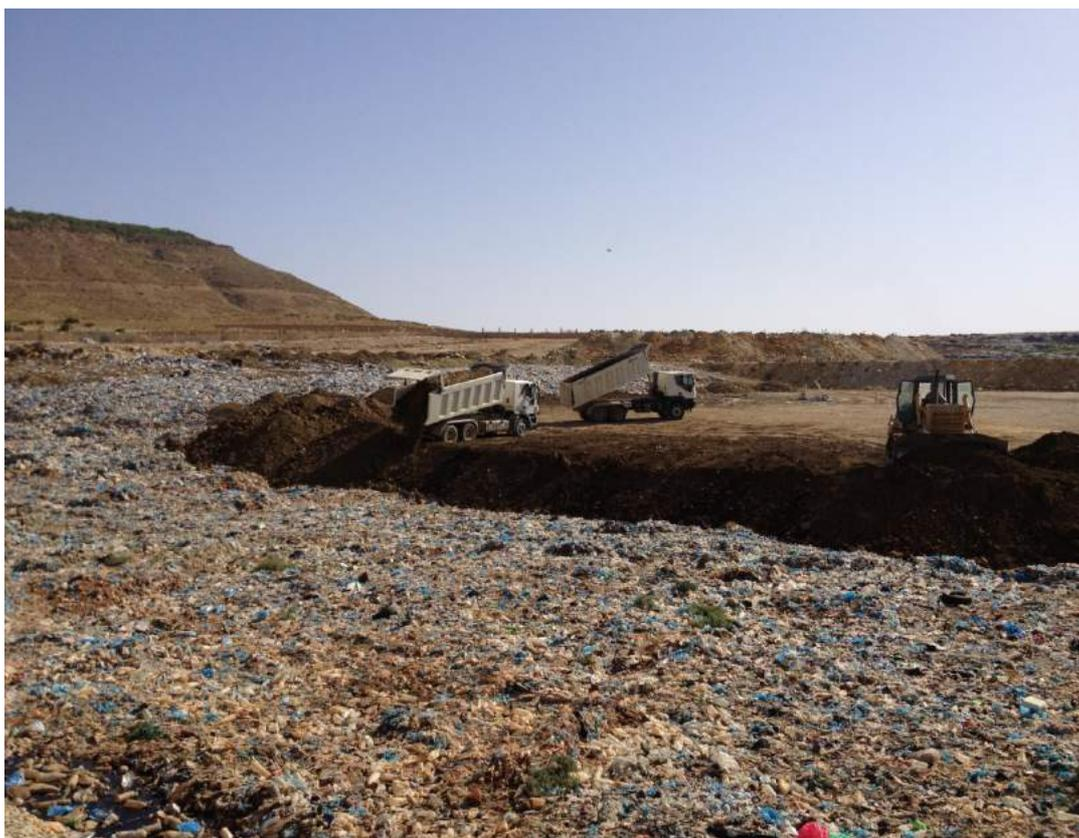
**Figure IV-4:** Déversement des déchets à l'extérieur du casier de stockage.
