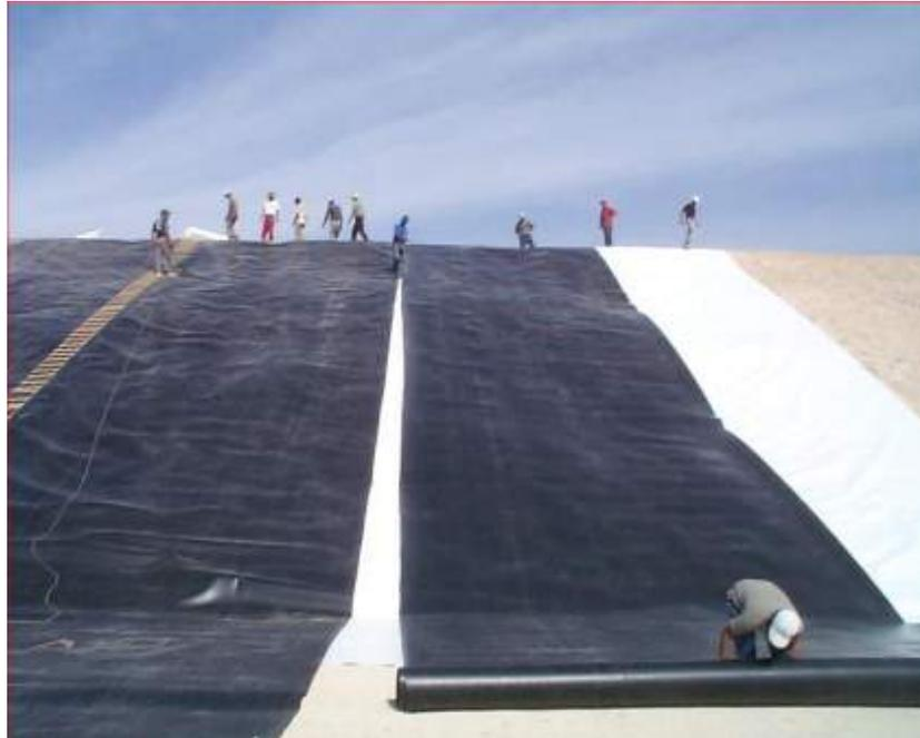
**Figure III-3:** la disposition du géotextile et de la géomembrane sur les flancs d'un casier, (Bouarfa, 2018)
