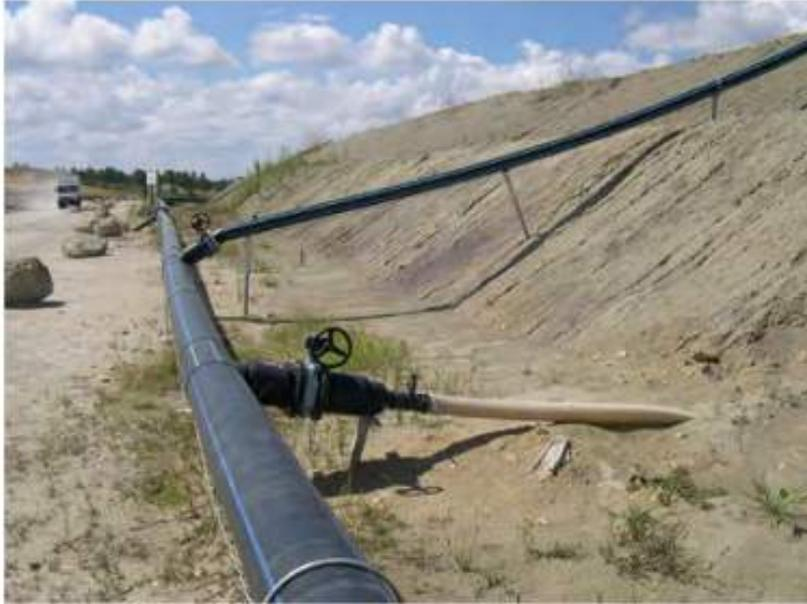
**Figure III-12:** raccordement des tranchés drainants en surface. (Ademe, 2007) .
