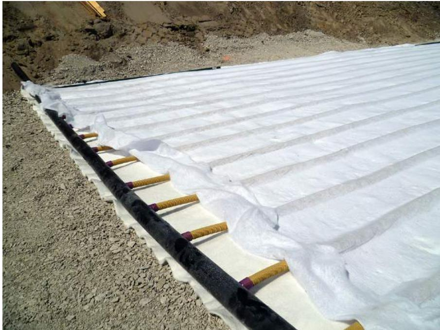
**Figure III-5:** drainage en PEHD avec géotextile
