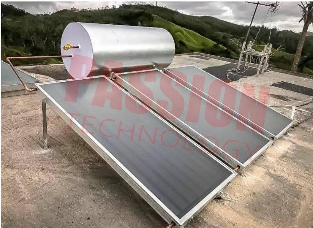
**Figure 1.5** : Photo d'un chauffe eau solaire
