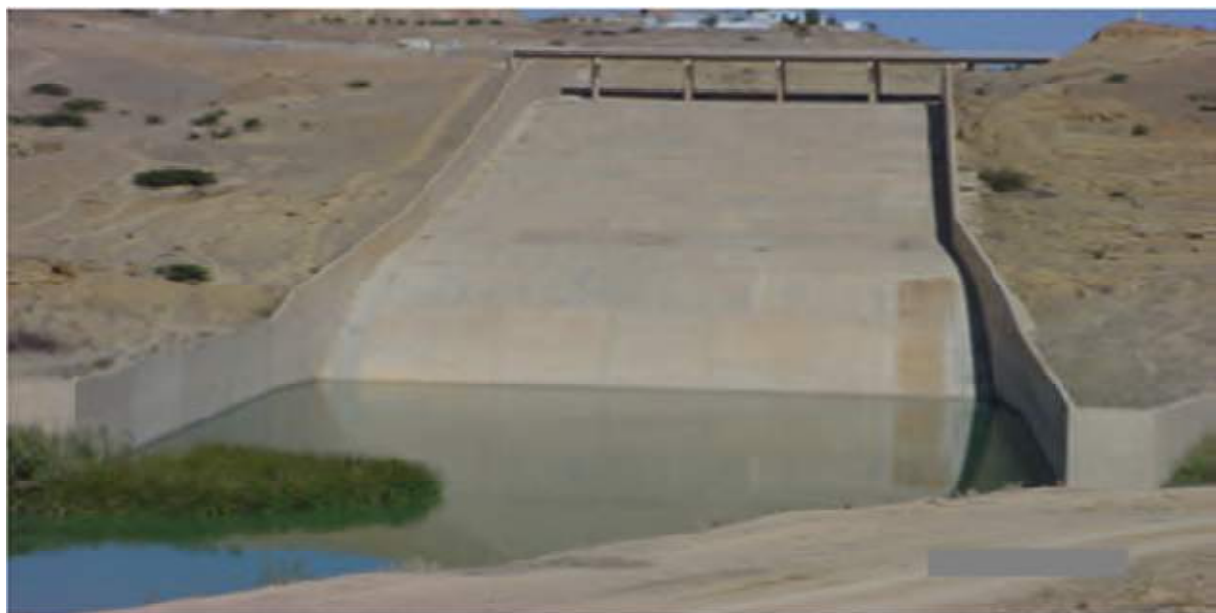
Figure V.2 Evacuateur de crue de barrage Sidi-Abdelli [ref.].
