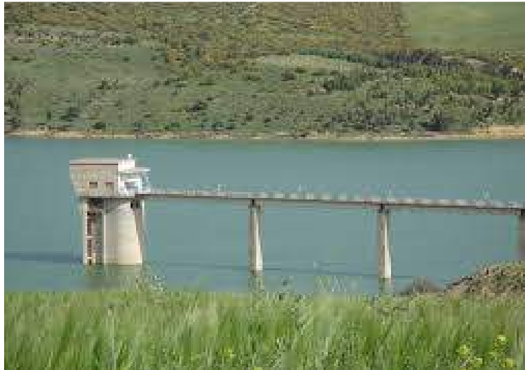
Figure III.13 Tour de prise d'eau de barrage Sidi-Abdelli.
