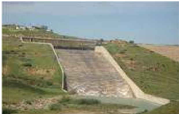
Figure III.15 Evacuateur de crue de barrage Sidi-Abdelli.
