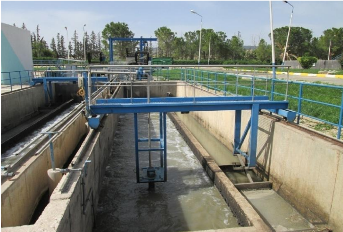
Figure 2-4: le procédé du dégraissage, déshuilage.
