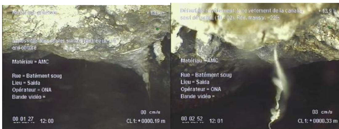
Figure V.12 : Vue intérieur du collecteur à partir d'un regard de Bâtiment soug à l'aide d'appareil d'auscultation.
