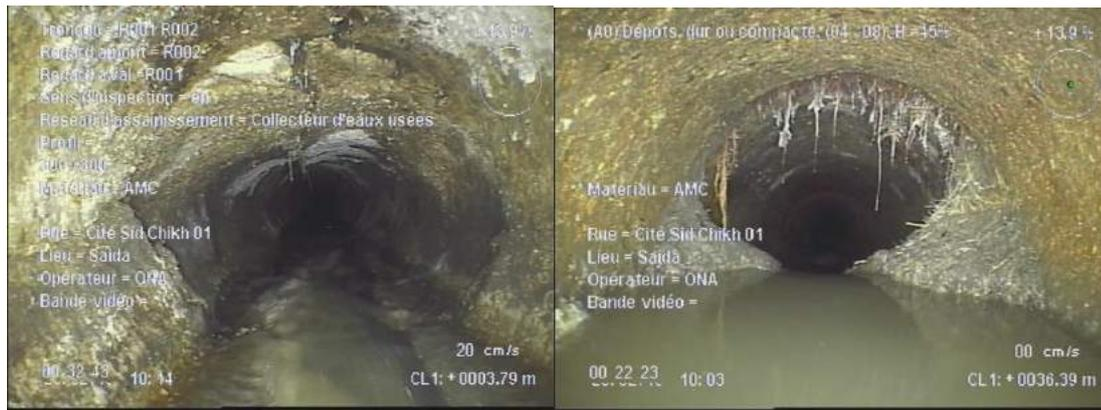
*Figure V.13 : Vue intérieur du collecteur à partir d'un regard de Sid chikh à l'aide d'appareil d'auscultation.*
