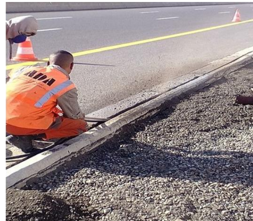
Figure IV-20 : Nettoyage des caniveaux à fente lit d'arrêt d'urgence PK 70 (1088) Côté Nord.
