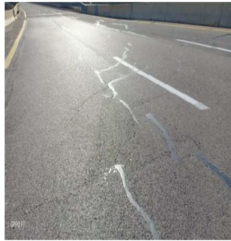
Figure IV-11 : Fissures sortie de viaduc PK 109+400 (1127+400) côté Nord.
