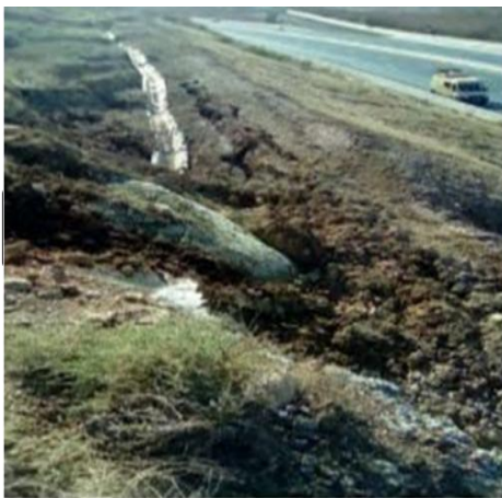
Figure IV-11 : Fissures sortie de viaduc PK 109+400 (1127+400) côté Nord.
