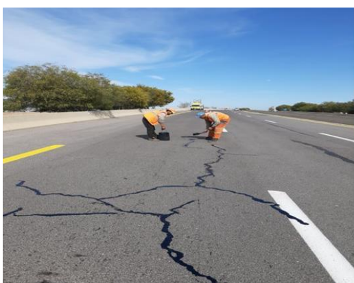
Figure IV-16 : Colmatage des fissures PK 107(1125) Côté Nord
