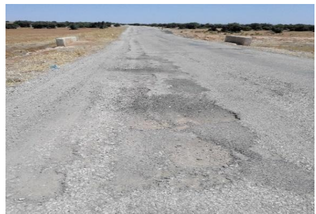
Figure IV-31 : les arrachements.
