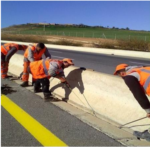
Figure IV-18 : Nettoyage des caniveaux à fente PK 89 (1087) Côté Sud.
