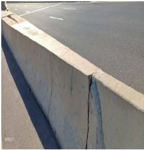
Figure IV-11 : Fissures sortie de viaduc PK 109+400 (1127+400) côté Nord.
