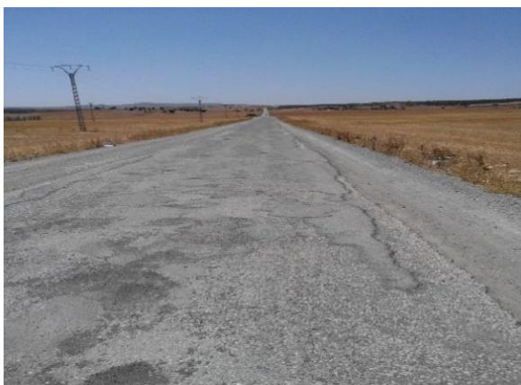
Figure IV-31 : les arrachements.
