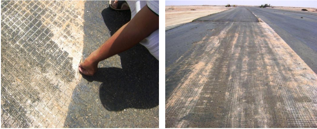
Géotextile utilisée pour le renforcement Les travaux de renforcement sont en cours
