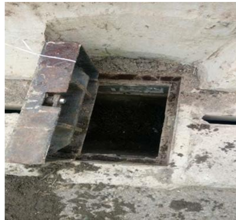
Figure IV-19 : Nettoyage des caniveaux à fente PK 89 (1107) Côté Nord.
