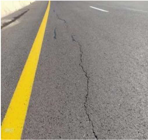
Figure IV-13: Fissures PK 114+100(1132+100) Côté Nord.
