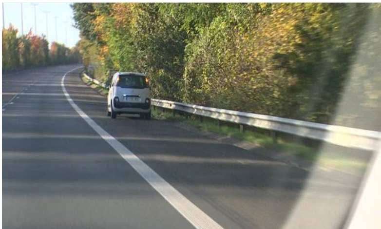
Figure I-21 : La bande d'arrêt d'urgence (BAU)
