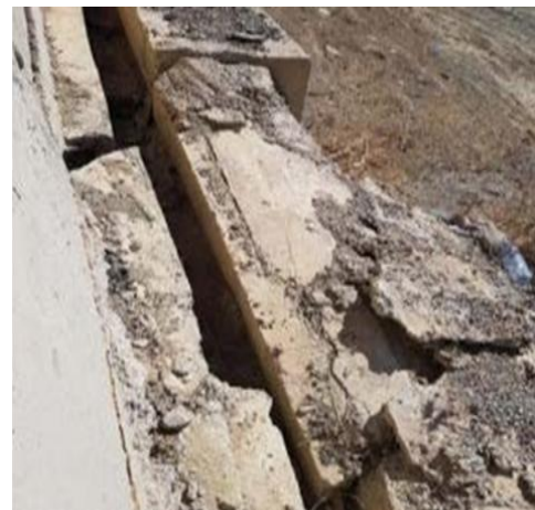
Figure IV-9 : Désordres caniveau rectangulaire PK 46+850 (1064+850) Côté Sud.
