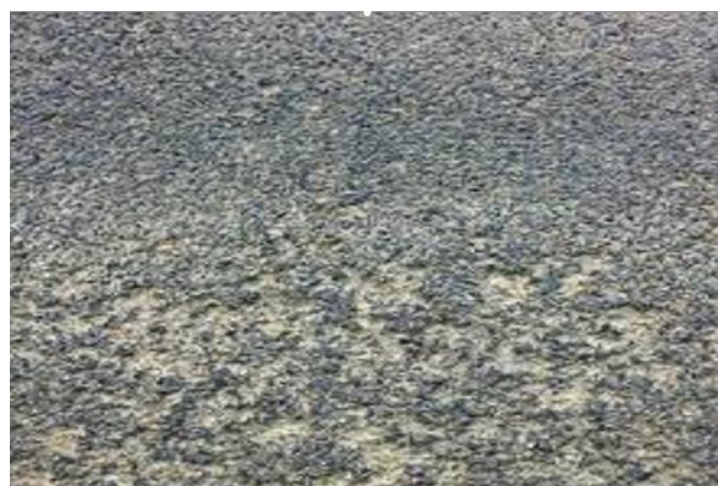
Figure II-9 : les arrachements.
