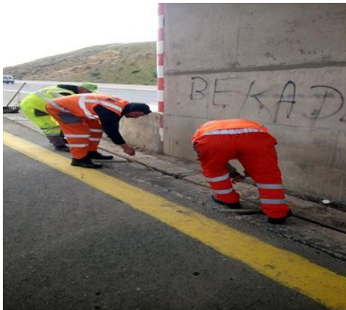
Figure IV-19 : Nettoyage des caniveaux à fente PK 89 (1107) Côté Nord.
