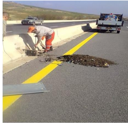
Figure IV-18 : Nettoyage des caniveaux à fente PK 89 (1087) Côté Sud.
