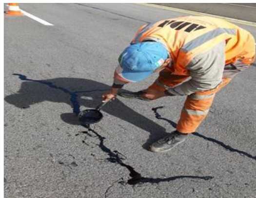
Figure IV-15 : Colmatage des fissures PK106 (1124) Côté Nord.
