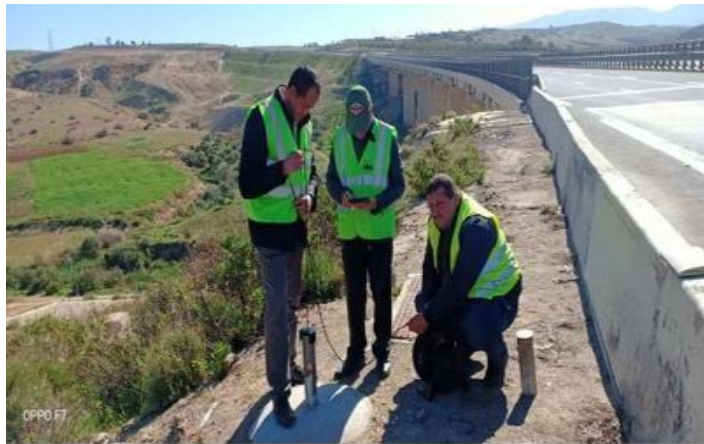
Figure IV-1 : PK 109+700(1127+400) Côté Nord
