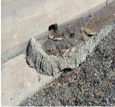
Figure IV-7 : Dégradation au niveau de Lit d'arrêt d'urgence PK48+147(1066+147) côté Nord.
