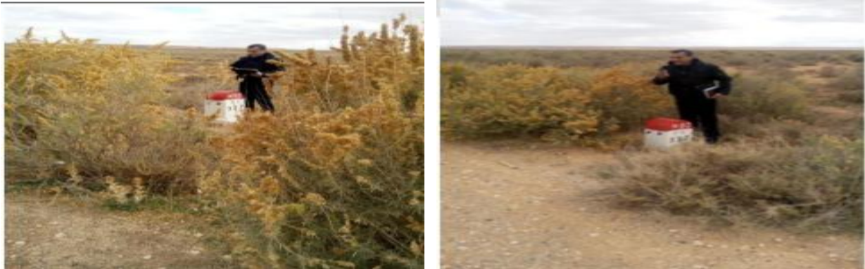
Figure IV-25 : vérification des bornes kilométriques
