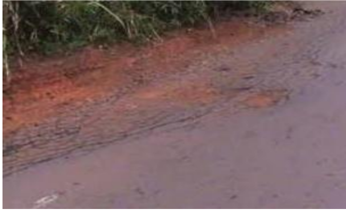
Figure II-18 : les épaufrures.
