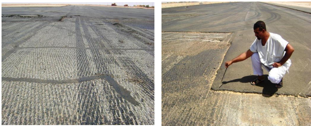
Les travaux de reprofilage en cours Les travaux sur la piste principale presque achevés
