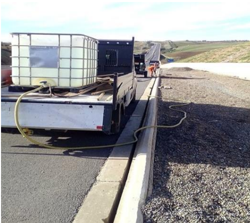
Figure IV-20 : Nettoyage des caniveaux à fente lit d'arrêt d'urgence PK 70 (1088) Côté Nord.
