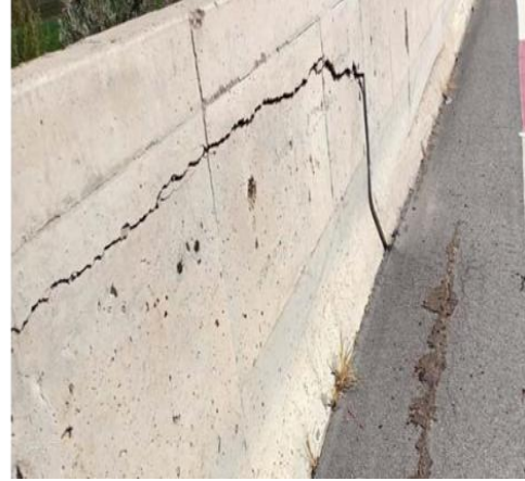
Figure IV-7 : Dégradation au niveau de Lit d'arrêt d'urgence PK48+147(1066+147) côté Nord.
