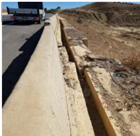
Figure IV-9 : Désordres caniveau rectangulaire PK 46+850 (1064+850) Côté Sud.
