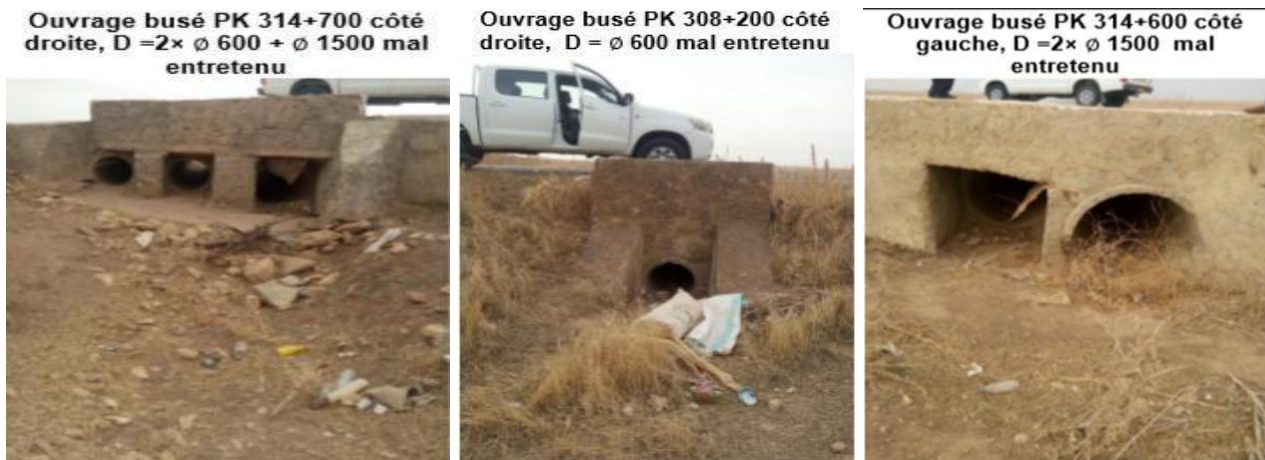
Figure IV-26 : Les photos des ouvrages busés envasées
