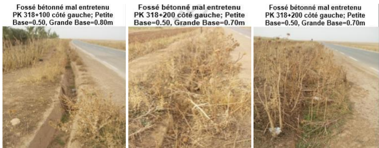
Figure IV-27 : Les photos fossés bétonnés obstrués par plantation
