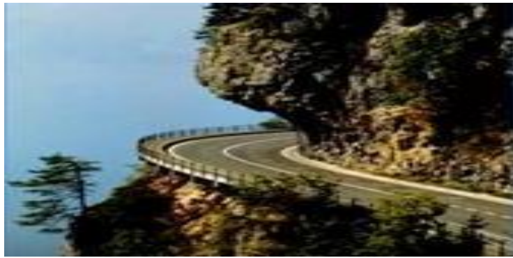
Figure I-20 : Talus en déblai roche massive / pont stable
