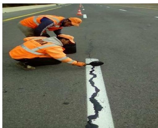
Figure IV-16 : Colmatage des fissures PK 107(1125) Côté Nord
