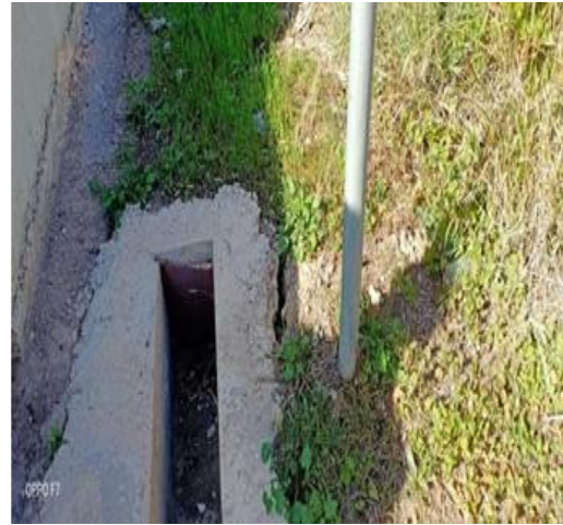
Figure IV-13: Fissures PK 114+100(1132+100) Côté Nord.
