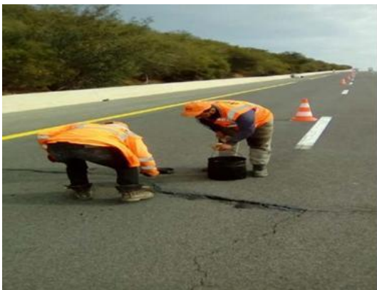
Figure IV-15 : Colmatage des fissures PK106 (1124) Côté Nord.
