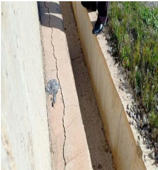
Figure IV-14 : Fissures au niveau de caniveau rectangulaire et décollement de GBA PK118 (1136) Côté Sud.
