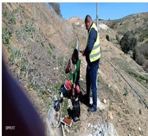
Figure IV-5 : PK46+100(1064+100) Côté sud
