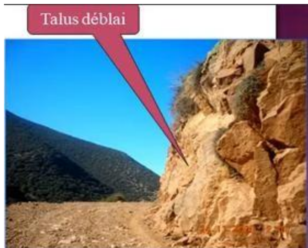
Figure I-19 : Talus en déblai rocheux / ponté presque verticale
