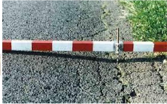
Figure II-1 : les affaissements. [20]
