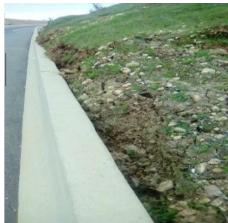
Figure IV-11 : Fissures sortie de viaduc PK 109+400 (1127+400) côté Nord.
