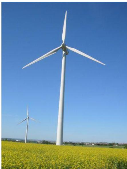
Figure (I.7): Eolienne à Axe Horizontal
